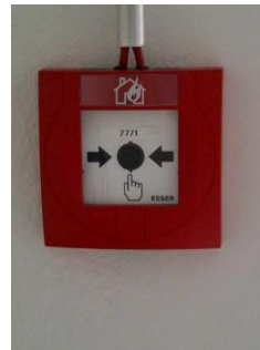
Handdruckmelder zur Alarmierung der Feuerwehr
